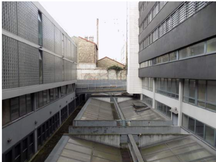
Bâtiment A, le bâtiment avec pavés de verre et la verrière
