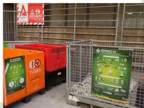
Tri des déchets sur le chantier du futur lycée
