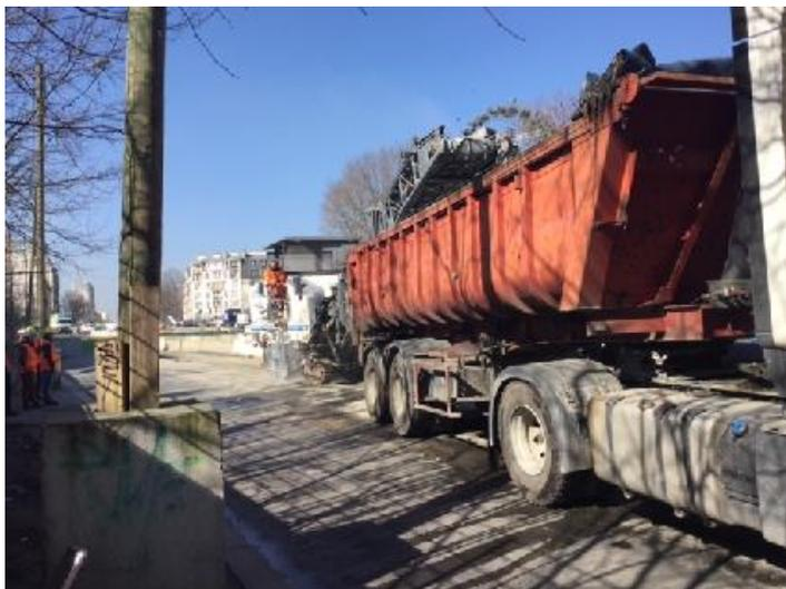
La fraiseuse dévore une section de béton de 1 mètre de large sur 0.2 m de haut .... et elle avance assez vite !!!
