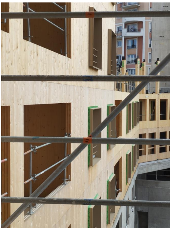
Façades « Jardin » en attente de revêtement ITE + enduit mince
