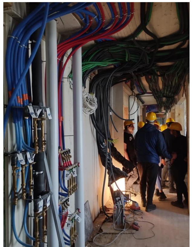
Installation des réseaux - Corps d'états techniques
