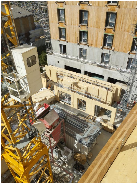
Stockage des voiles préfabriqués bois CLT sur pupitres.
